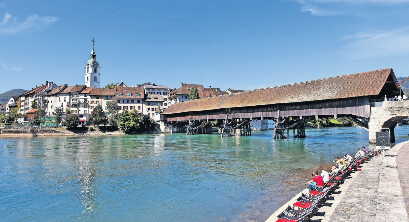
Holzbrücke Altstadt Olten
