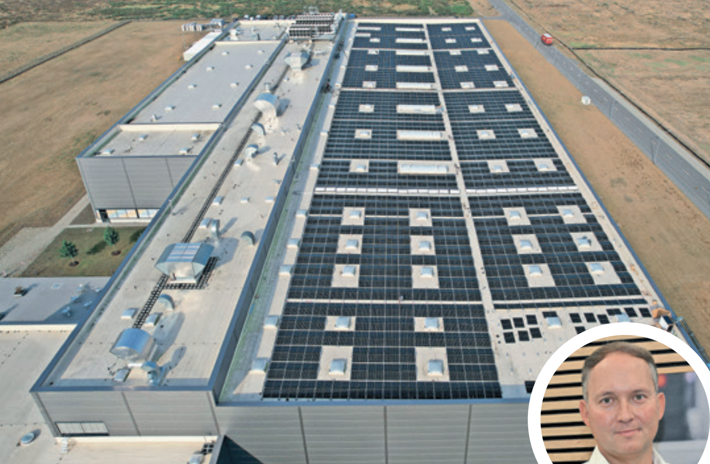
Photovoltaik-Anlage auf dem Dach der Ypsomed
