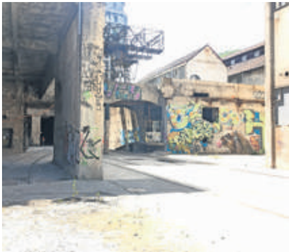
Vorher: Hier wird ein zentraler Treffpunkt des Attisholz-Areals entstehen.
