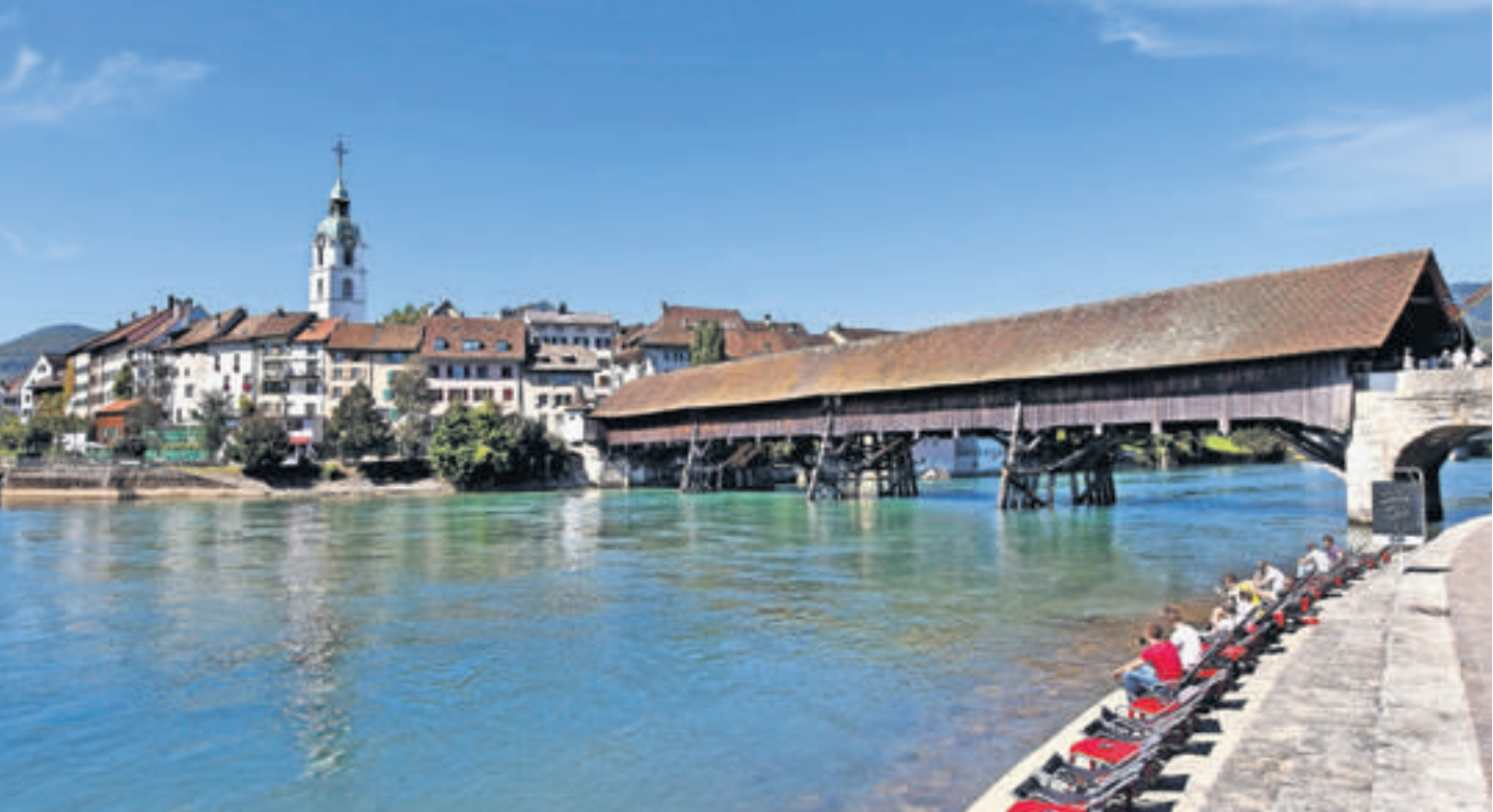
Holzbrücke Altstadt Olten
